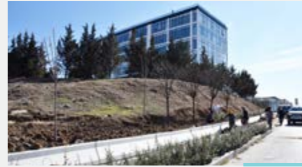
OSTİM Ağaçlandırma-Yol Bakım Onarım Çalışmaları
