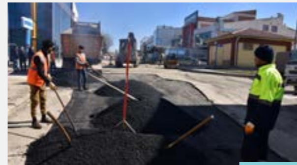
OSTİM Ağaçlandırma-Yol Bakım Onarım Çalışmaları
