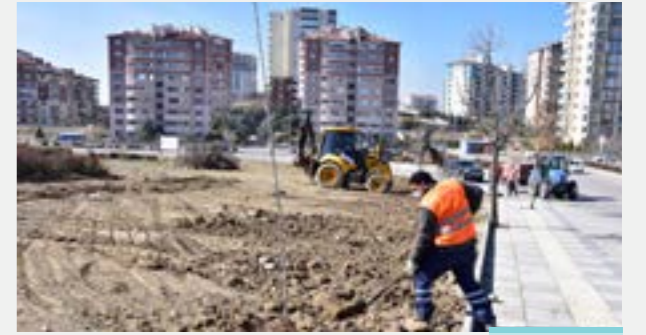
OSTİM Ağaçlandırma-Yol Bakım Onarım Çalışmaları
