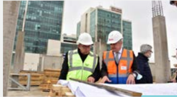
OSTİM Merkez Camii İnşaat Denetimi
