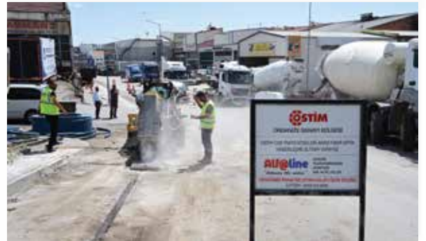
Trafolar Arası Fiber Haberleşme Altyapı Yapımı 23 Mayıs 2025
